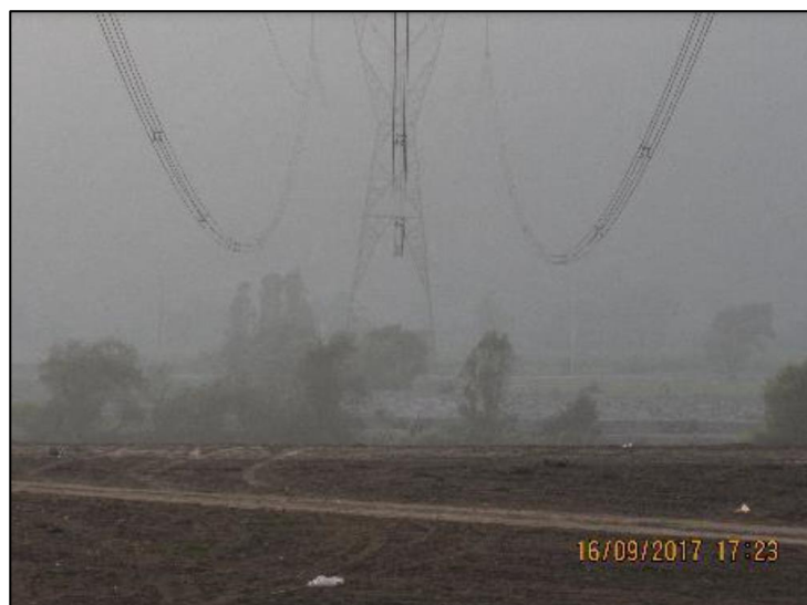
Figura 16: Vano de la Torre T07 de la L5006
