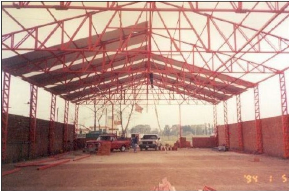
Figura 2.8 Armaduras de techo
