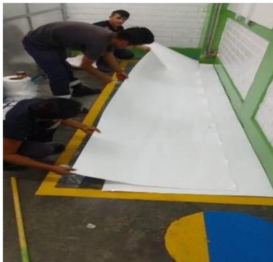
Ilustración 20: Cambio de lámina de piso
